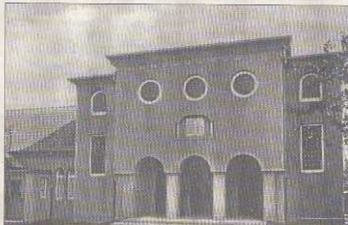
Die 1929 errichtete Synagoge an der Cramerstraße wurde in der Nacht zum 10. November 1938 niedergebrannt. BILD: MUSEUM
